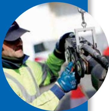
Inspection des réseaux par caméra vidéo
