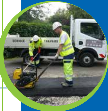
Travaux génie civil Pose de canalisations
